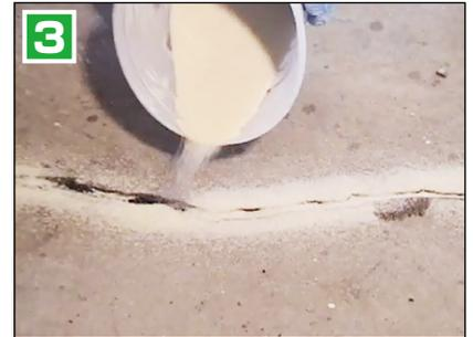
3 ひび割れ部に接着補強材（ケイ砂）を撒きます。
