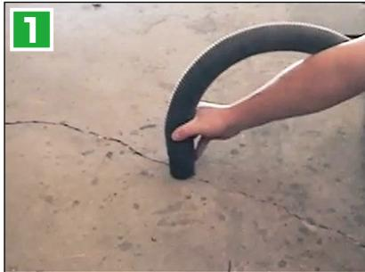
1 ひび割れ箇所のホコリや水気を掃除機で吸い取るかコンプレッサーで吹き飛ばします。
