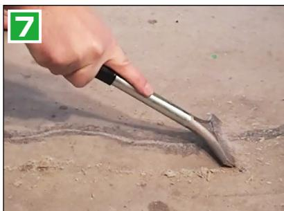
7 30分以降で表面の硬化を確認した後、スクレーパーではみ出た部分を取り除きます。
