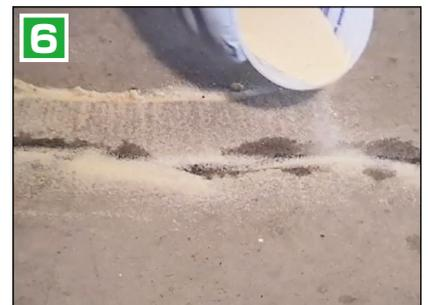
6 もう一度接着補強材を撒き、スクレーパーで馴染ませます。
